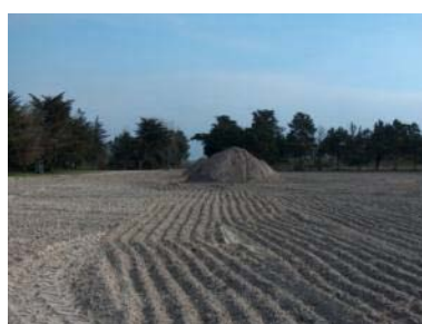
Travaux de restauration
