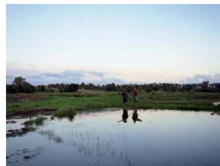
Mare de gabion sur le Vergon
