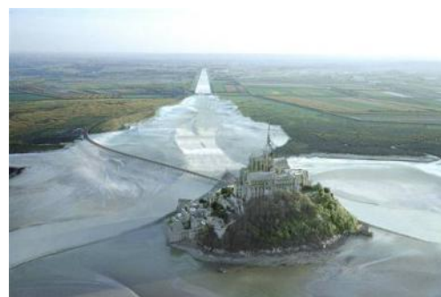
Le Mont après les travaux (image de synthèse) © SM Baie du Mont
