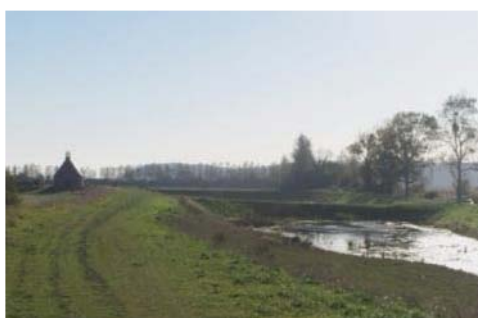
La chapelle Sainte-Anne après travaux
