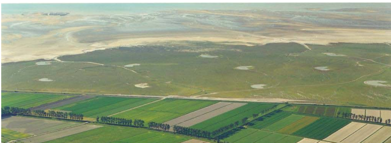
Gabions sur les herbus au droit du polder Taigny à Roz-sur-Couesnon
