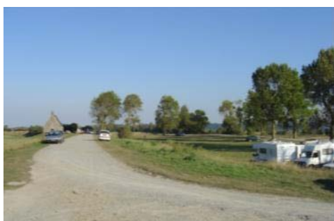
La chapelle Sainte-Anne avant travaux
