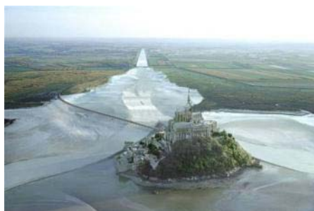
Le Mont après les travaux (image de synthèse)
