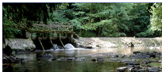
Barrage sur la Druance
